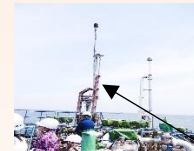
タンカーと陸側配管を接続する設備
