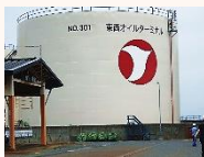
最大の石油タンク
