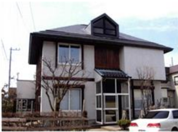
図 68 住宅（無落雪屋根への改修前）
