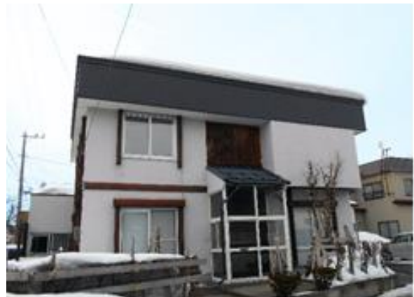
図 69 住宅（無落雪屋根への改修後）
