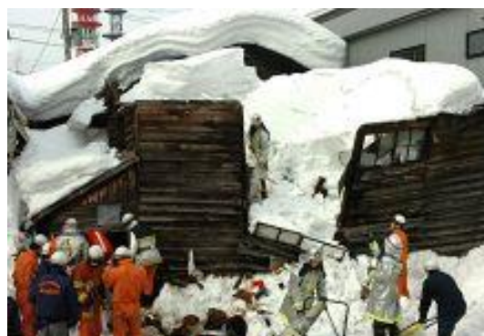
図 25 雪の重みで倒壊した家屋
