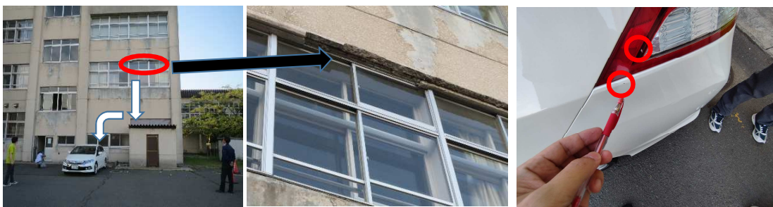
落下したコンクリートの動き
