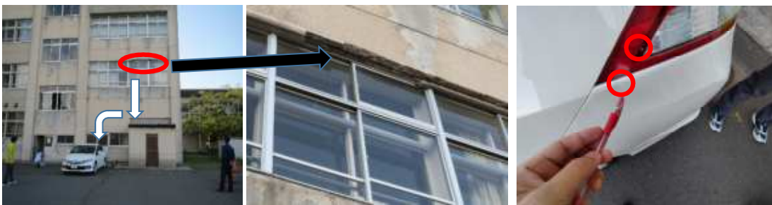
落下したコンクリートの動き
