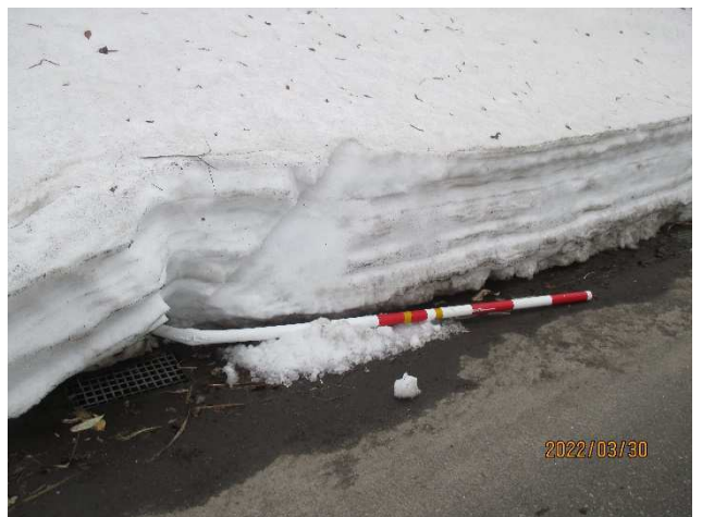
スノーボールの折損状況
