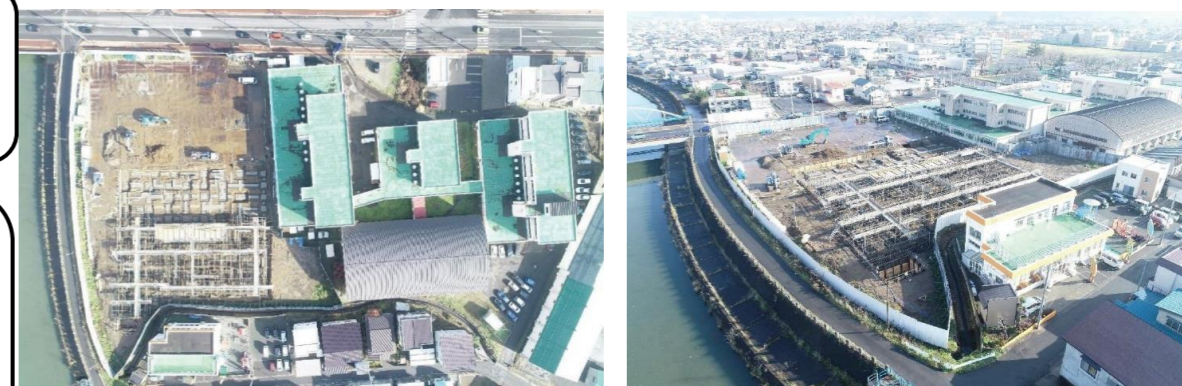
●工事状況（令和3年11月30日撮影）
