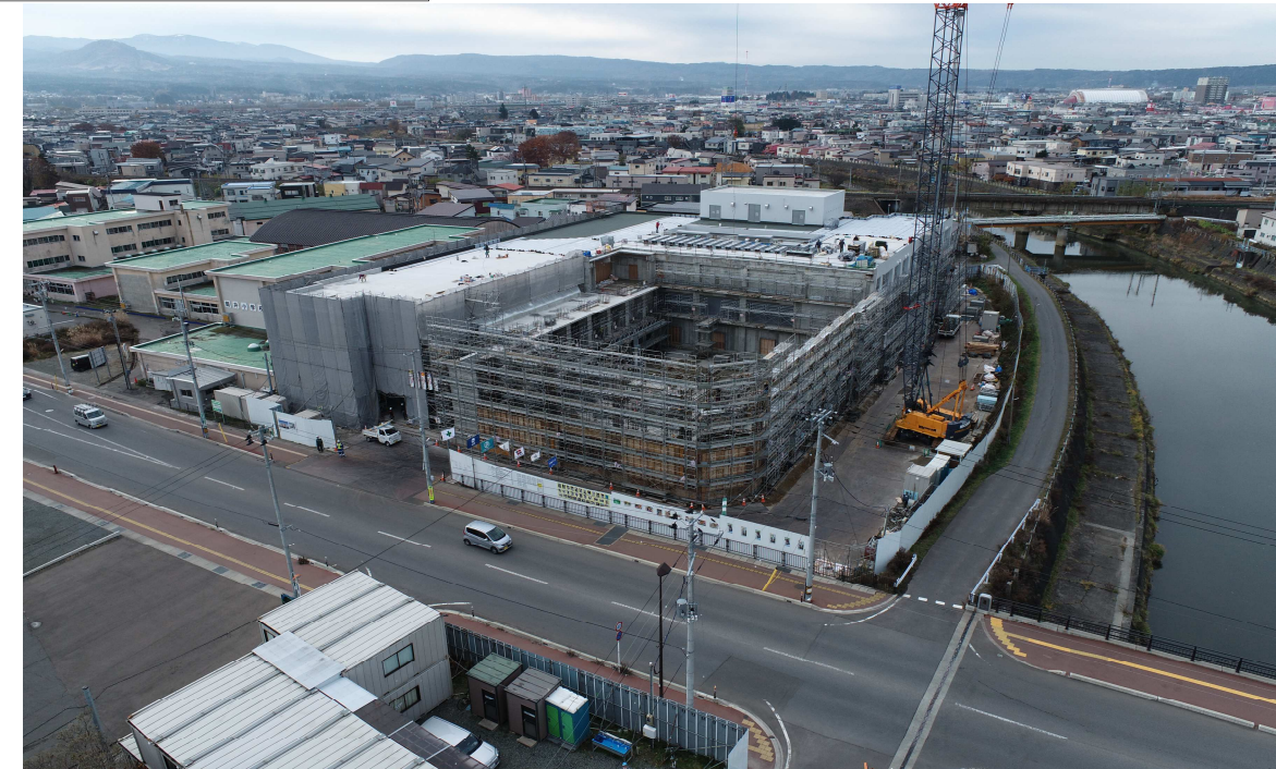
工事状況 (令和4年11月30日撮影)
