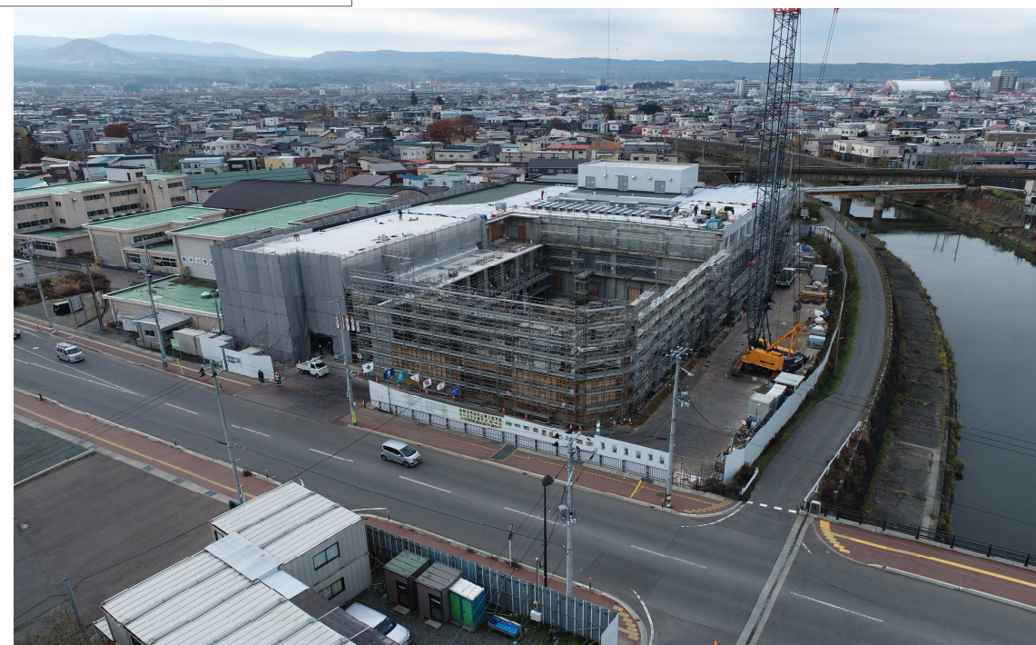
工事状況 (令和4年11月30日撮影)
