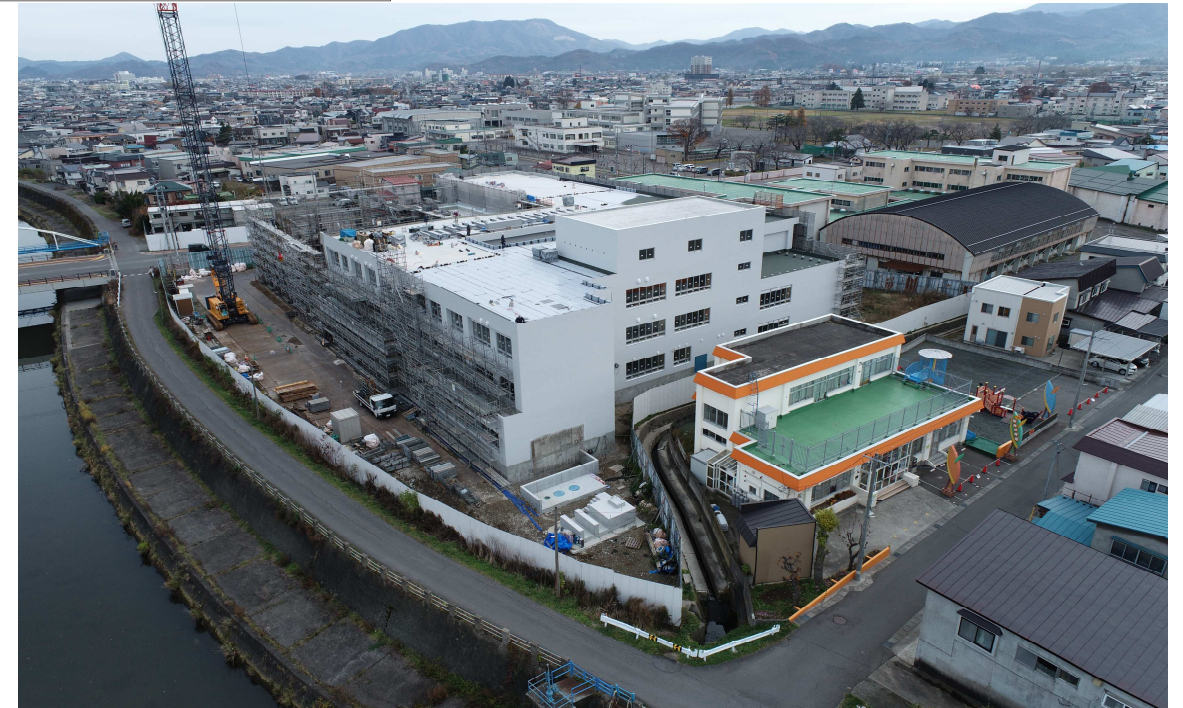
工事状況 (令和4年11月30日撮影)
