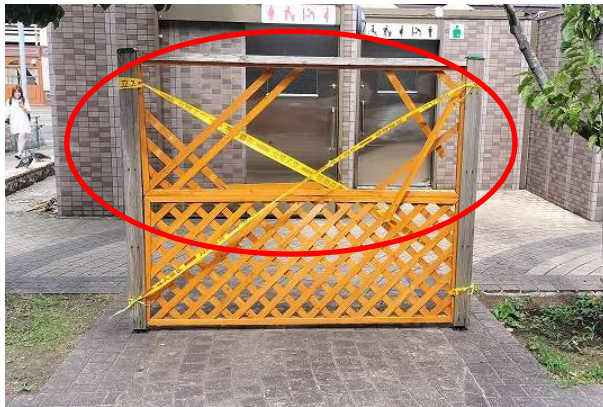
(○箇所 衝立破損被害箇所)
