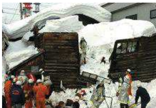
図 24 雪の重みで倒壊した家屋
