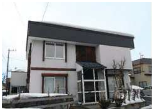
図 68 住宅（無落雪屋根への改修後）
