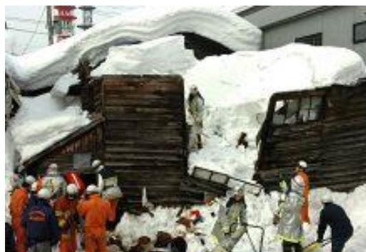
図 25 雪の重みで倒壊した家屋
