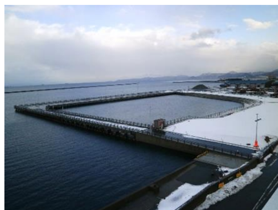
図 74 青森港本港地区緑地（浜町） 雪処理施設
