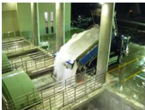
図 73 八重田浄化センター内 積雪・融雪処理槽
