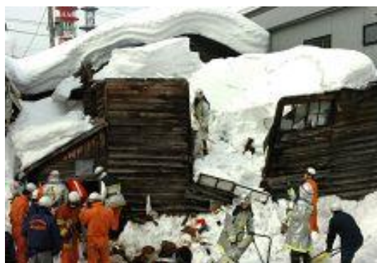
図 81 雪の重みで倒壊した家屋
