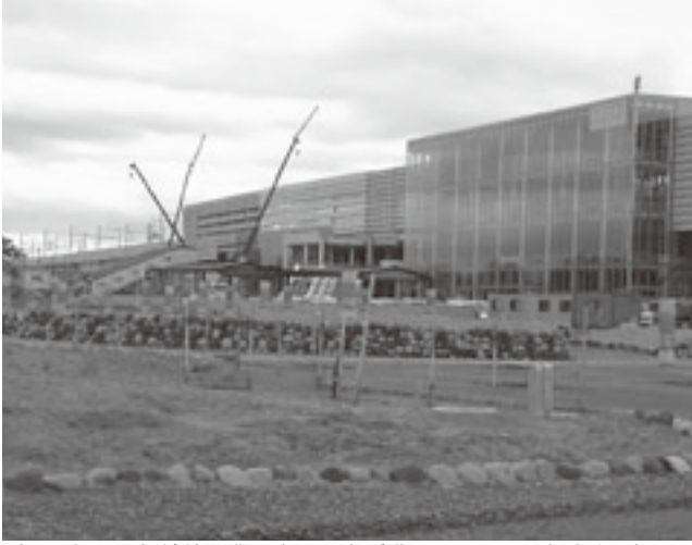
〈2010年12月新幹線開業に向け工事が進められている新青森駅〉
