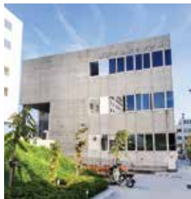
地域外来は市役所本庁舎隣の急病センター棟です。
