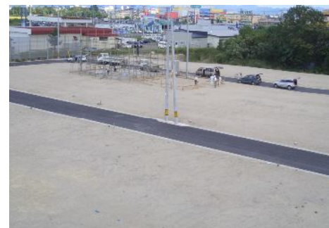
住宅新築状況遠景
