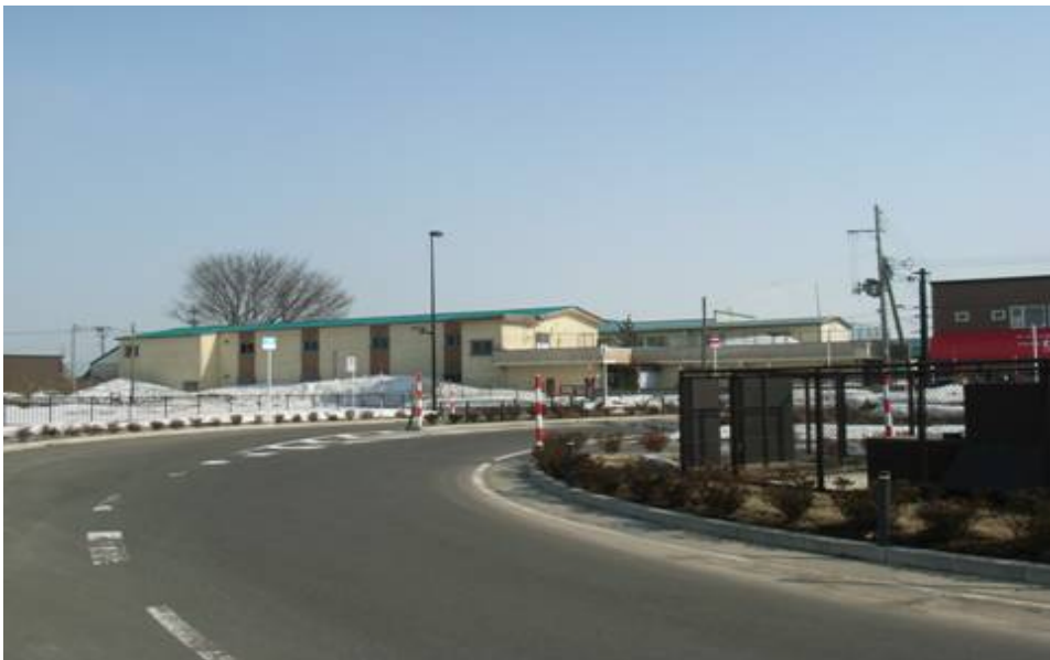
北西方向より
