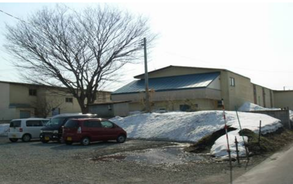
北東方向より
