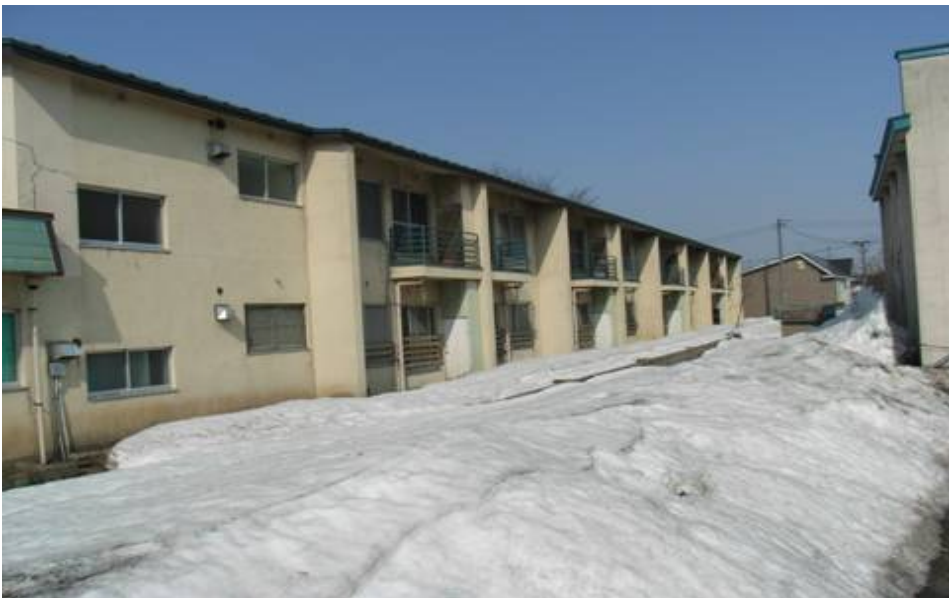
南西方向より
