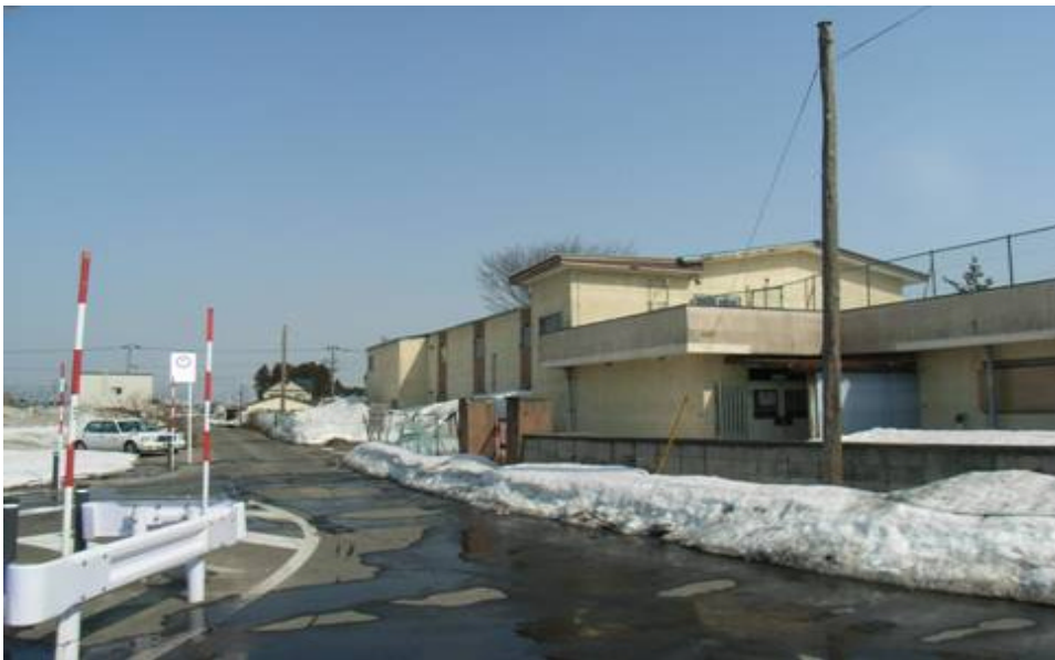
北西方向より
