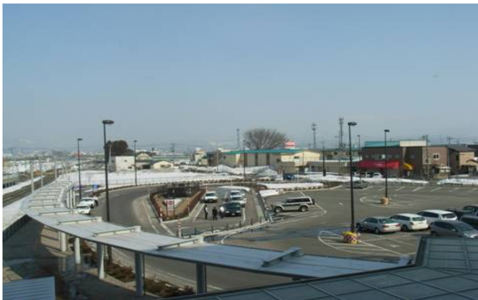
新青森駅舎内より
