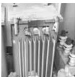
低圧コンデンサーは、工作機械や揚水ポンプ、業務用冷凍・冷蔵庫、業務用エアコンなどのモーターで稼働する電気機器の力率を改善する目的で壁面や配電盤などに取り付けられています。高圧コンデンサーや変圧器は、キュービクルや電気室・機械室などに設置されています。
