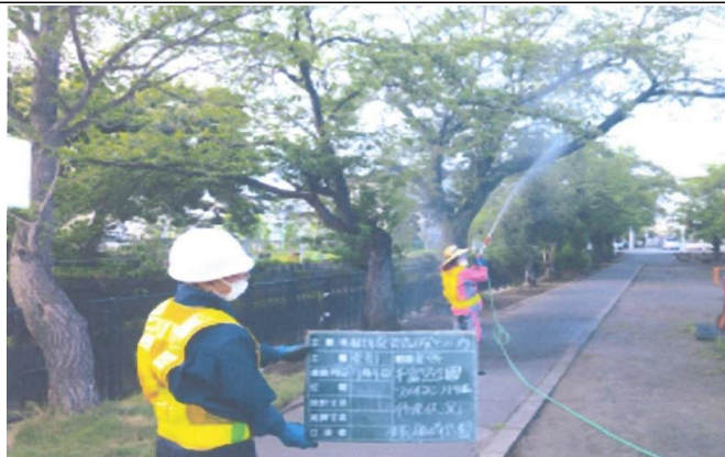
作業風景写真
