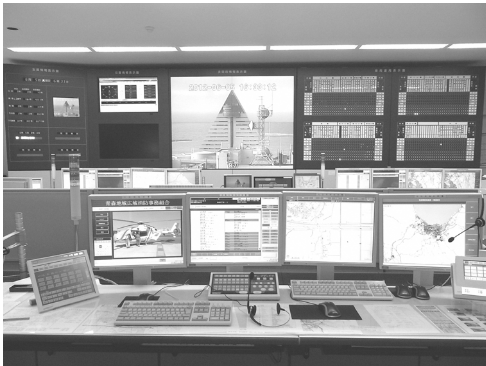
高機能消防指令システム
