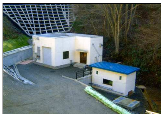
浸出水処理施設
