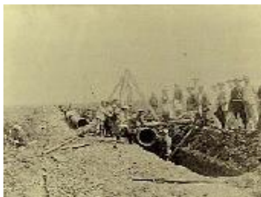
創設時の配水管の布設
