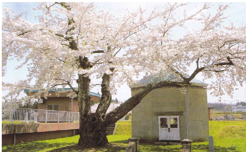
満開の桜に囲まれた横内浄水場の「旧配水井」。
