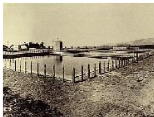
大正時代の横内浄水場
