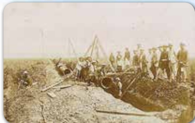
創設期の配水管布設
