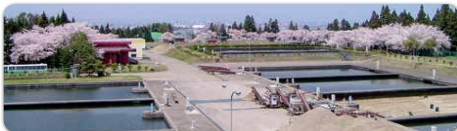
平成時代後期の横内浄水場
