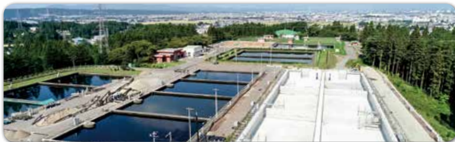
横内浄水場北系沈殿池更新工事（令和元年度）
