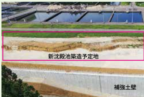
補強土壁が完成した横内浄水場
