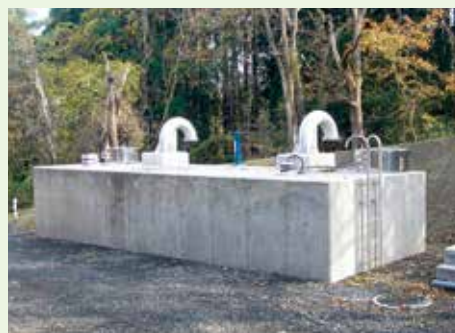
完成したばかりの浅虫サージタンク (サージタンク：送水管の圧力を調整する水槽)
