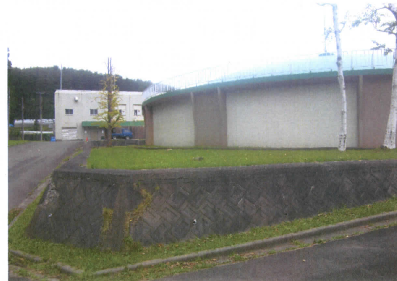
1号配水池の擁壁部分(間知ブロック積み)
