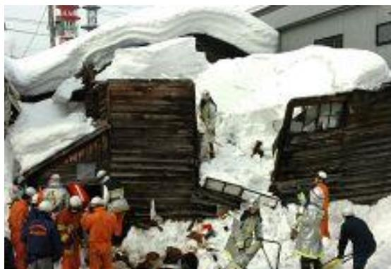
図 46 雪の重みで倒壊した家屋
