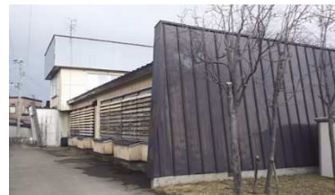
造道福祉館（現況）
