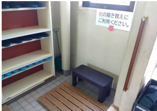
1階正面玄関の下駄箱前に設置した靴履き替え用の「腰掛と手すり」
